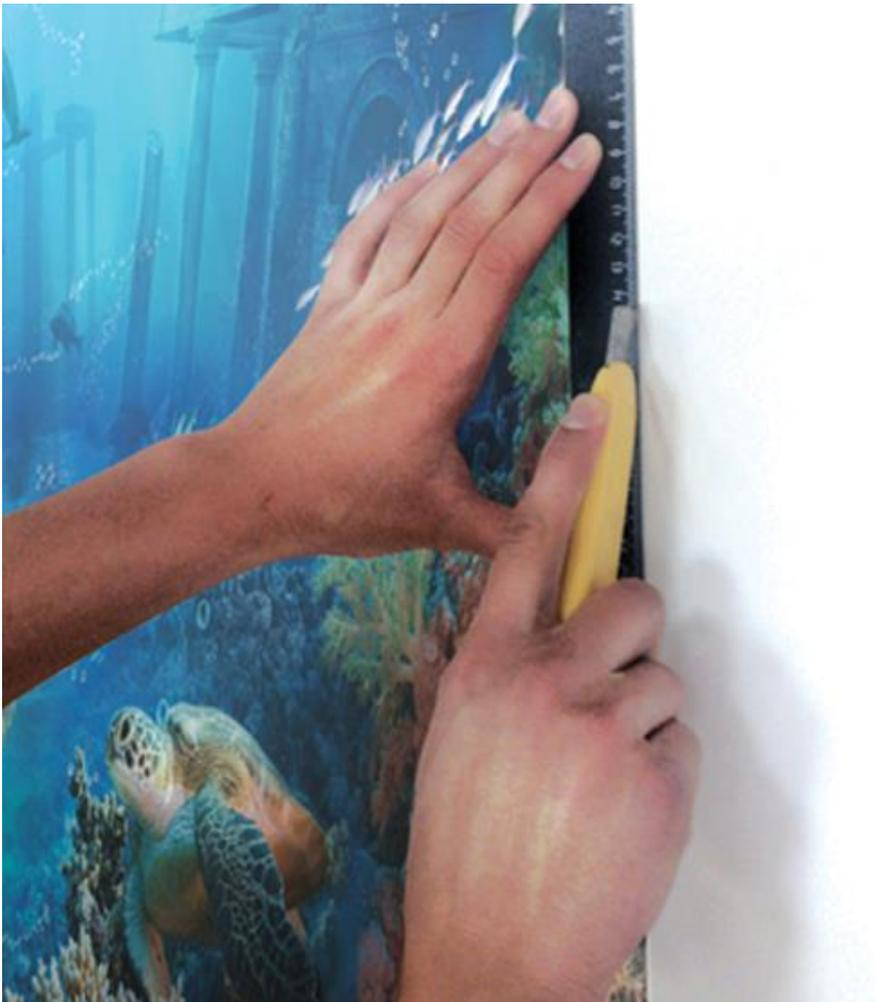
4. Край полотна подрежьте острым ножом по линейке или шпателю.
