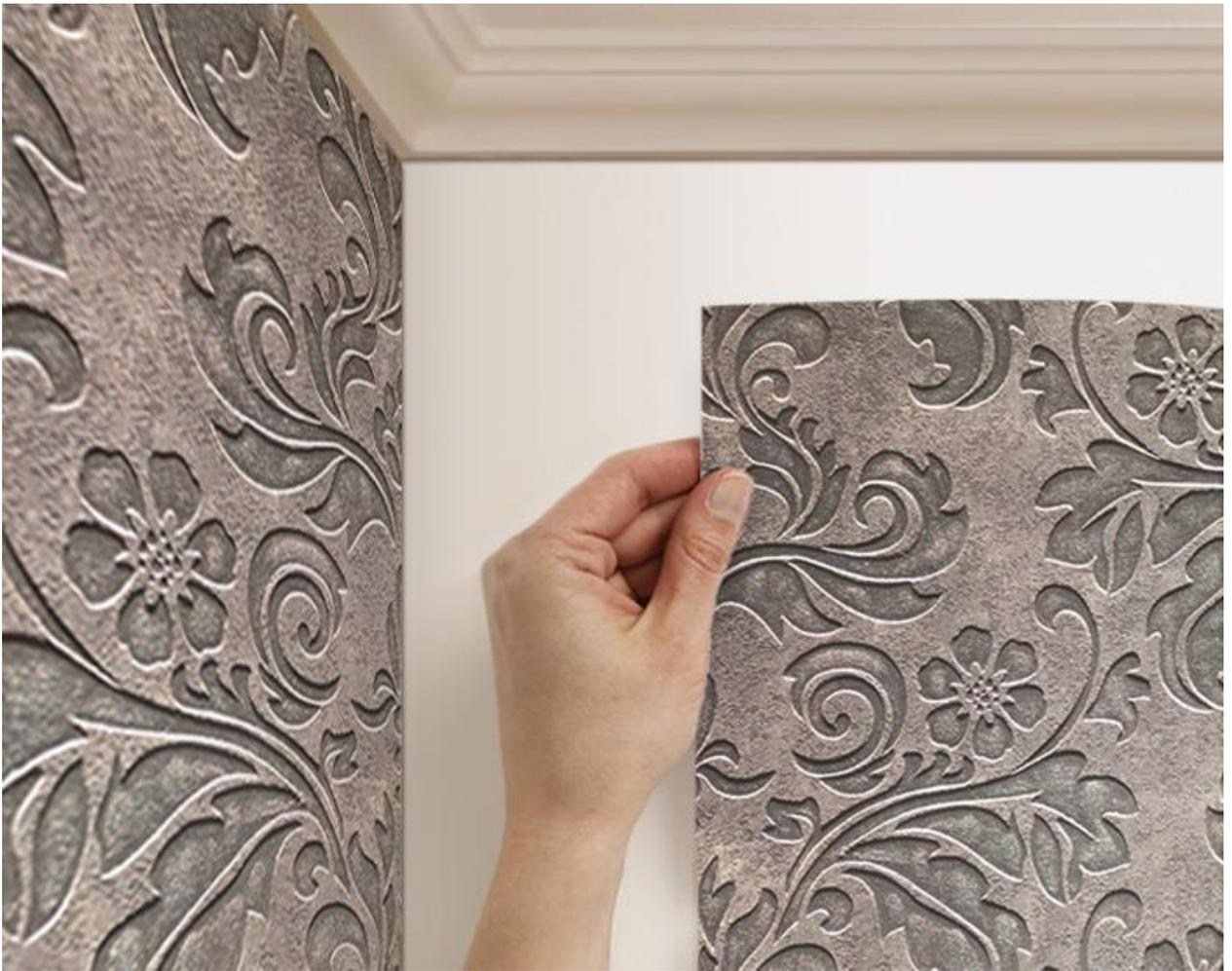
Рис. 5. Панно стыкуются строго в углах между стенами без нахлеста, стык в стык.
