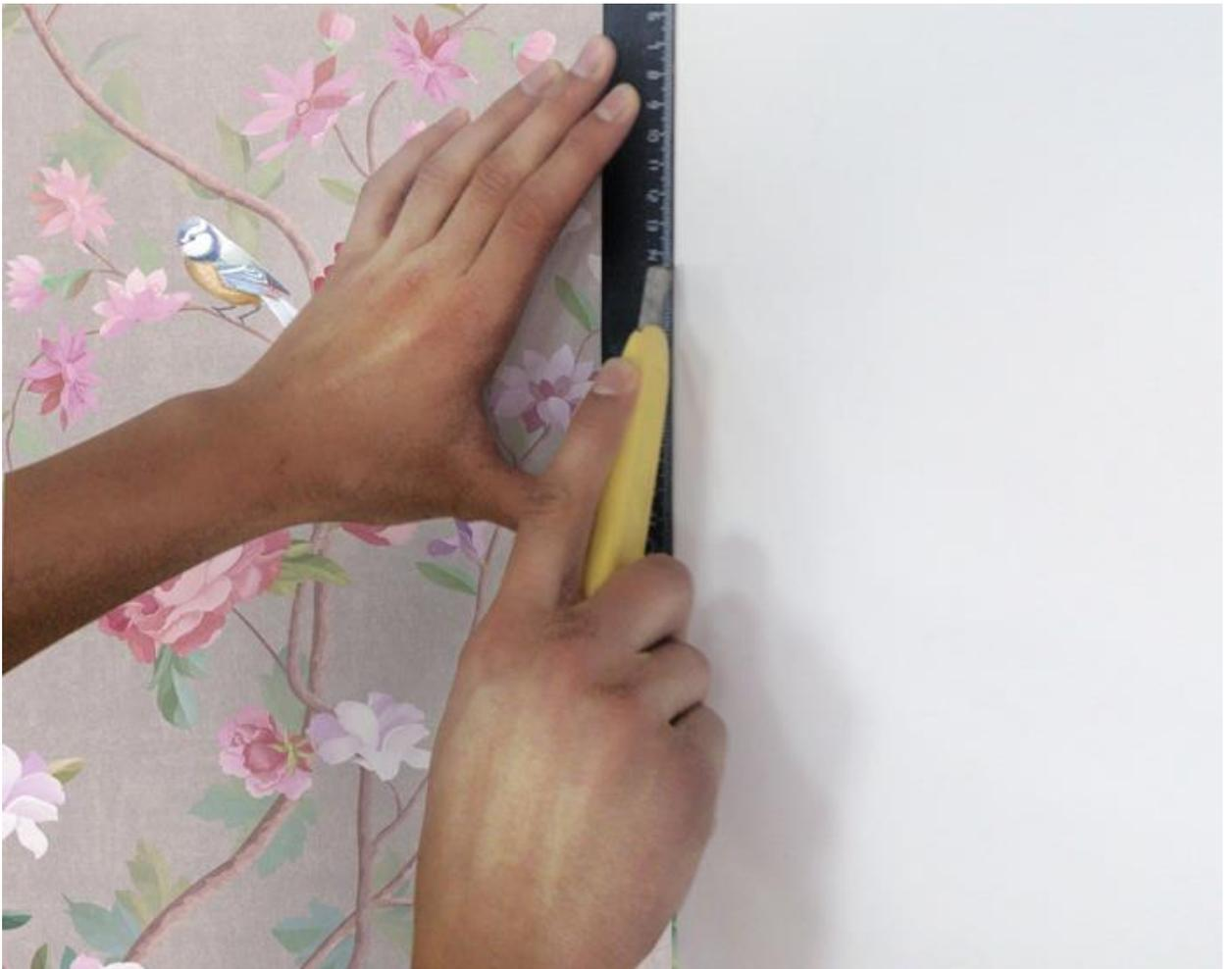
5. Край полотна подрежьте острым ножом по линейке или шпателю.
