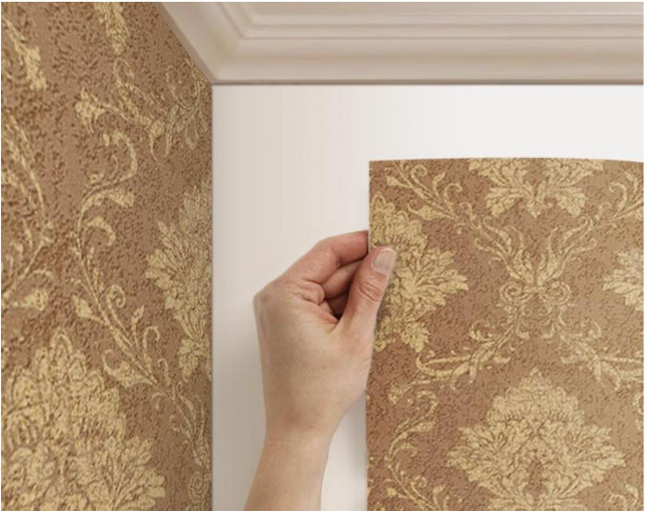
5. Полотна стыкуются строго в углах между стенами с нахлестом 3-5 см.
