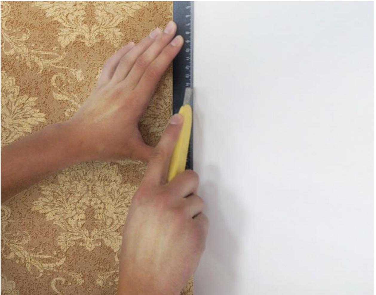
4. Край полотна подрежьте острым ножом по линейке или шпателю.
