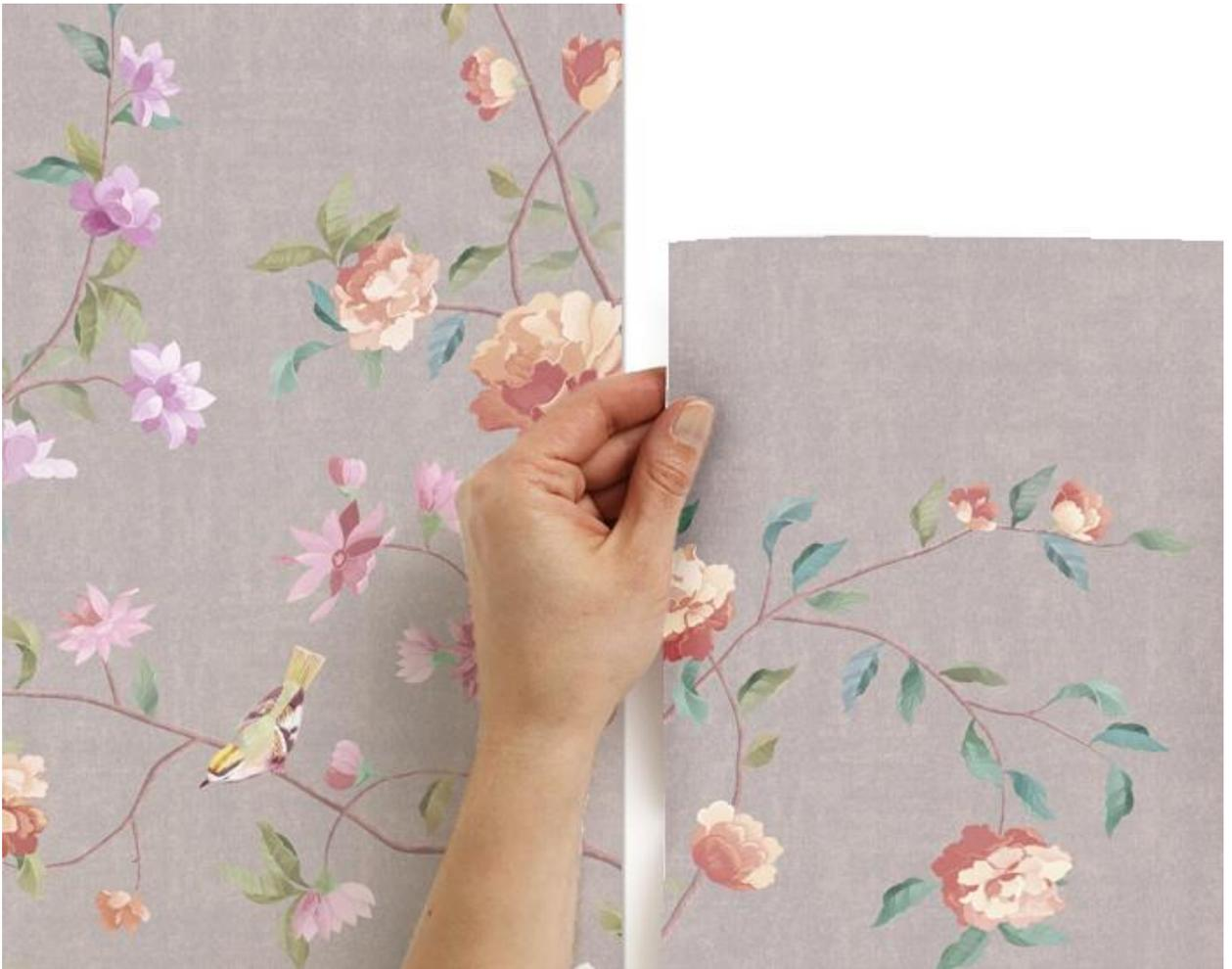
4. \*При монтаже панно, порезанного на рулоны. Последующее полотно клеится стык в стык к предыдущему, совмещая рисунок и фактуру.
