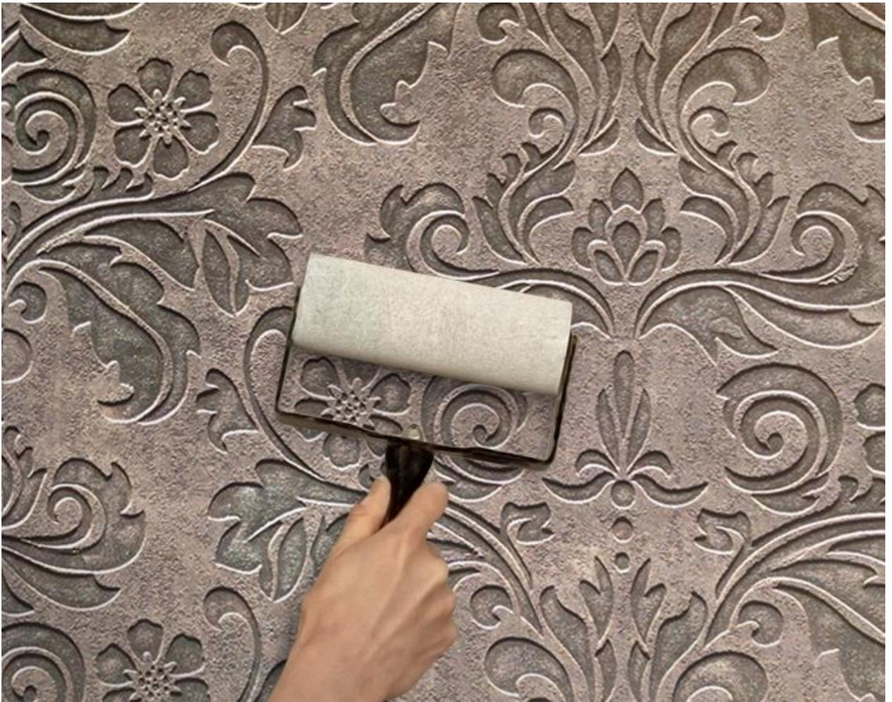
Рис. 3. Складки и пузыри разгладьте валиком для обоев или обойным шпателем.
