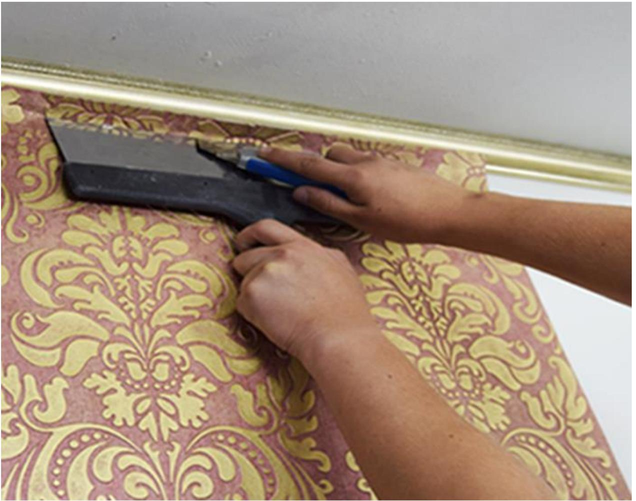
6. После монтажа с помощью ножа и шпателя удалите остатки обоев по потолку и полу.
