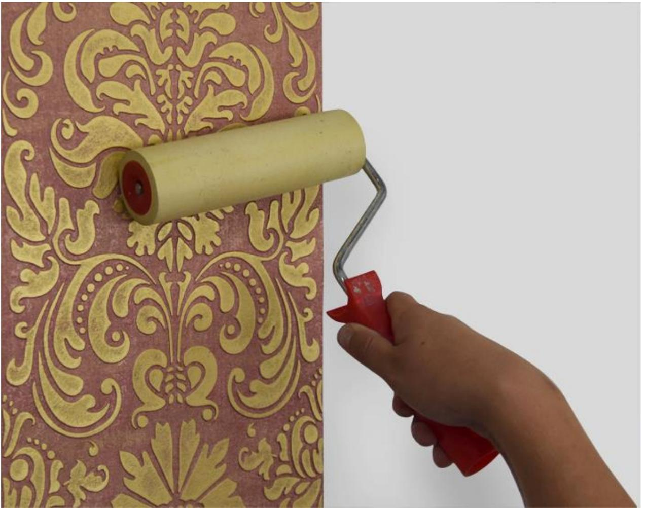
3. Прикатайте смонтированное полотно валиком для обоев, удаляя из-под полотна пузыри с воздухом и излишки клея.
