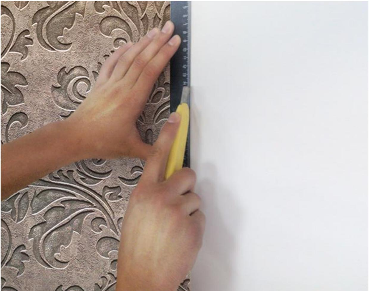
Рис. 4. Край панно подрежьте острым ножом по линейке или шпателю.
