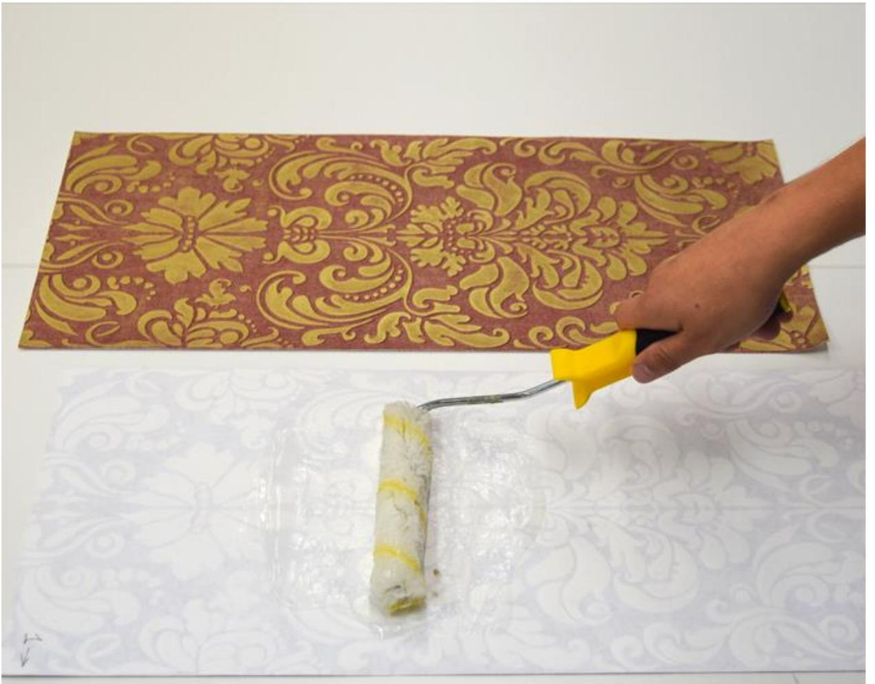
1. Нанесите клей на обратную сторону полотна и оставьте на 15-20 мин.
